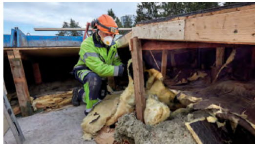
Snickaren Jon Österlund jobbar med isolering där det är problem med duvspillning. Vid rivning måste han ha heltäckande skyddsutrustning.
