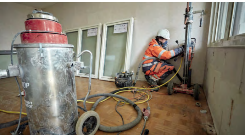
”Man måste tänka sig för när man jobbar i damm”, säger betonghåltagare Nicklas Jensen.
