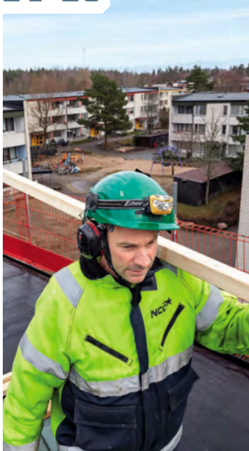
Mats Henningsson river och bygger nytt.
